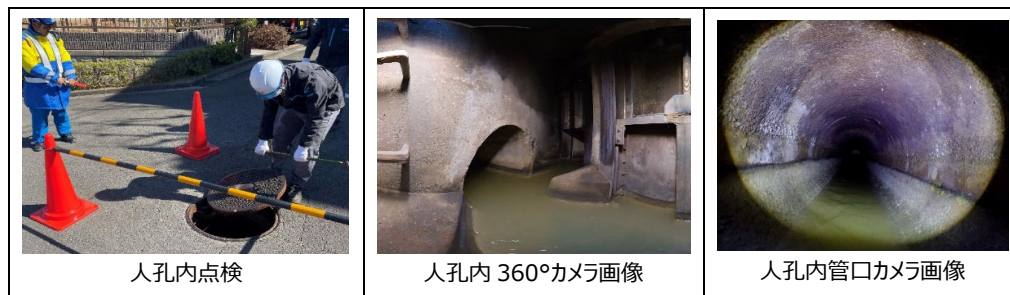
管路緊急自主点検状況
