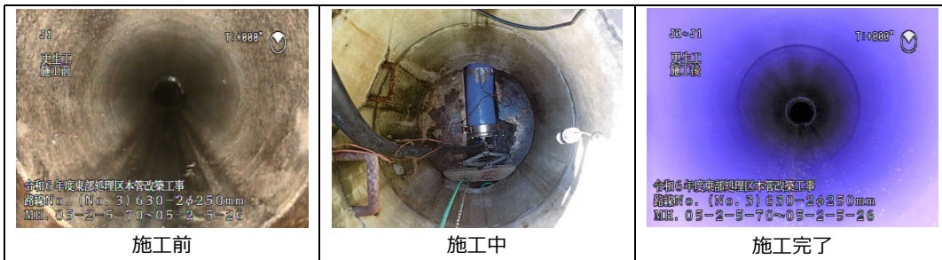
本管改築工事（管更生）（（１）改築・表 2-3-3）
