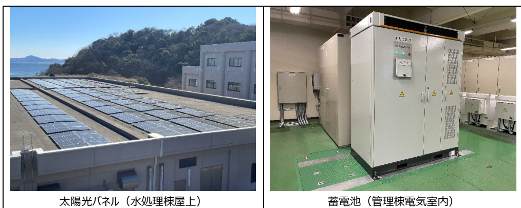
太陽光発電システム設置工事
