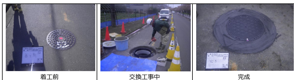
マンホール蓋交換工事
