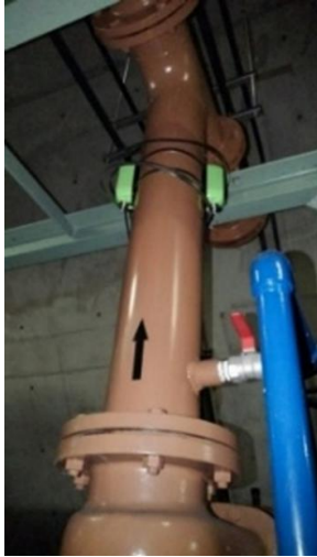
①クランプオン型濃度計（左）②ドップラー式流量計（中央）③ 非接触レベル計流量計（右）
